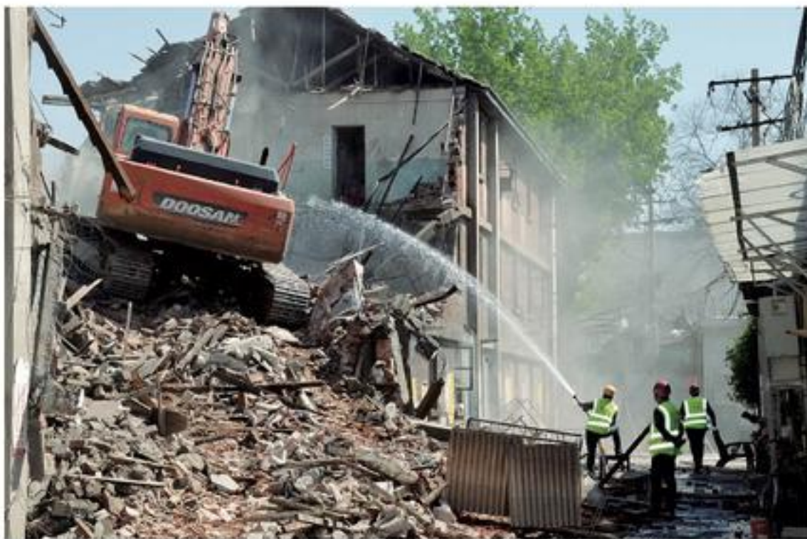
菜园街棚改项目中首座楼房拆除(枣林西里4号楼)
