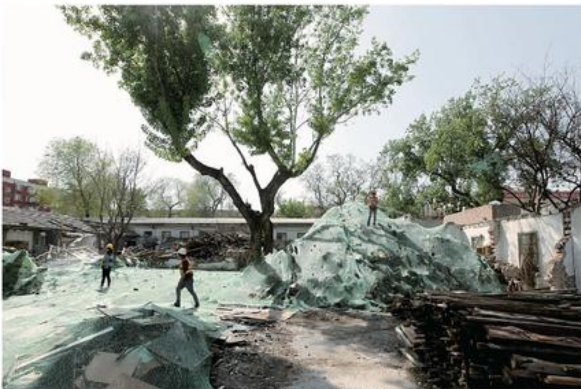
正在建设中的未来新家园
